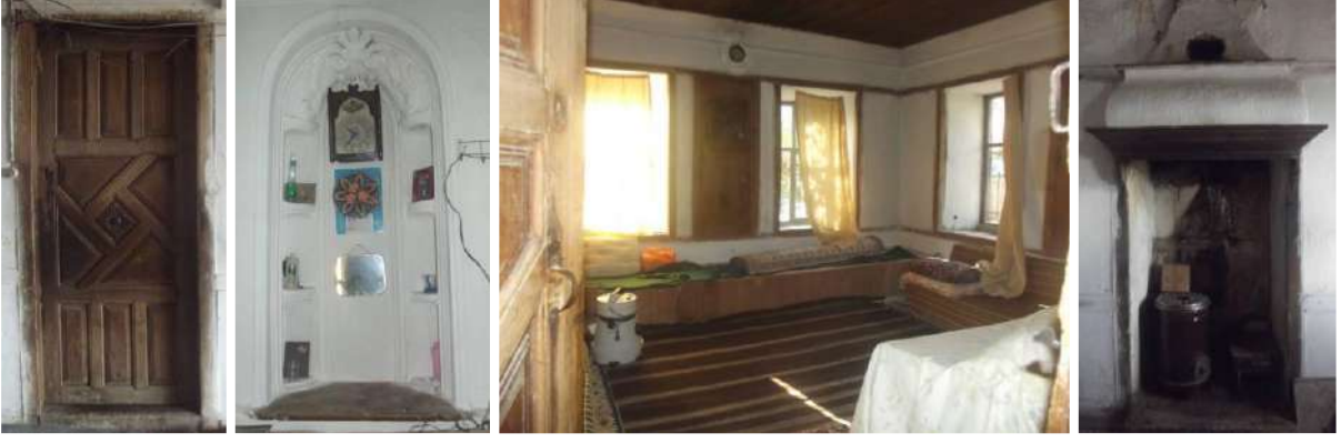
Şekil6. Zemin kattaki kapı, şerbetlik, sedir ve ocak iç mekân elemanları (Haştemoğlu, 2017)
